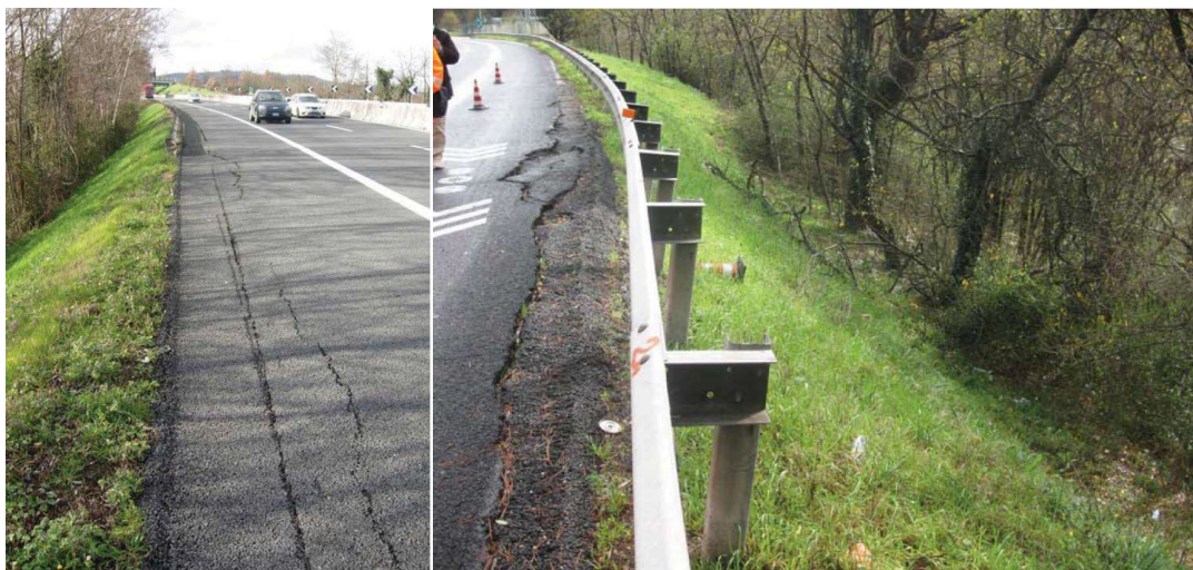
Foto 1 e 2,3: es. di instabilità banchine
