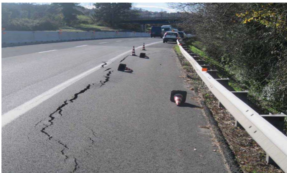
Foto 5: es. di instabilità del corpo del rilevato con lesioni ed evidenti cedimenti in corsia di emergenza e rigonfiamenti al piede della scarpata del rilevato.
