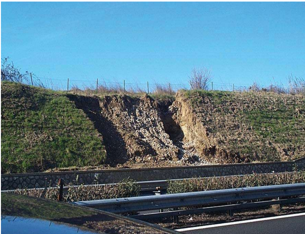
Foto 15: es. di erosione sulla trincea
