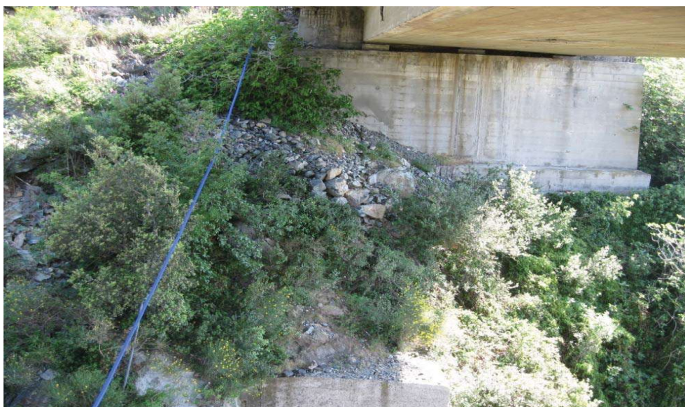
Foto 28 - 29: opera oggetto su entrambe le spalle da fenomeni di crollo di materiale roccioso del versante
