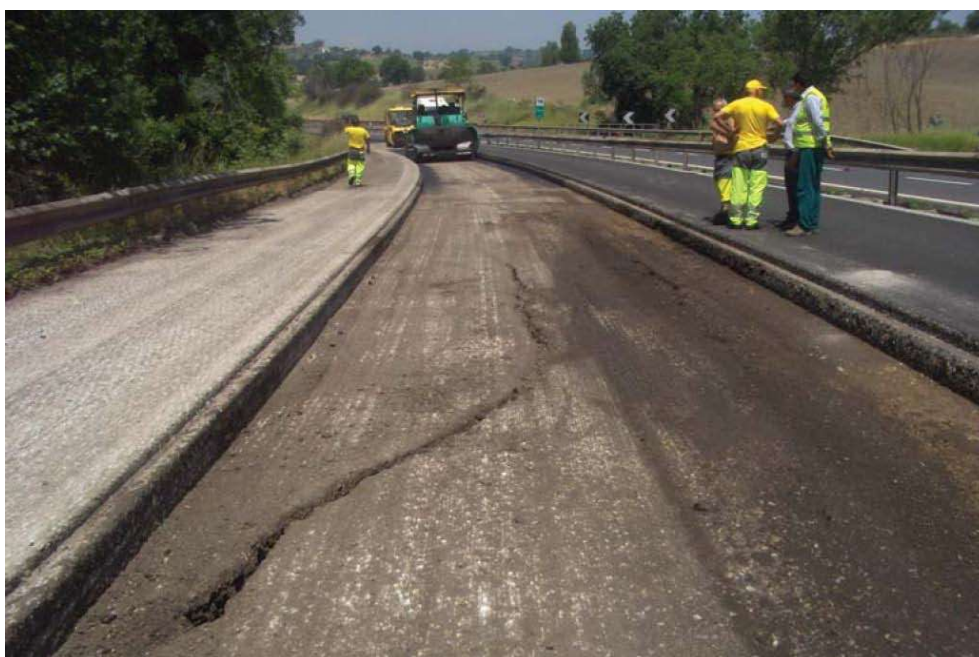
Foto 6: es. d'instabilità del corpo del rilevato - i lavori di fresatura hanno confermato la rottura del corpo del rilevato già evidenziato con lesioni sulla pavimentazione
