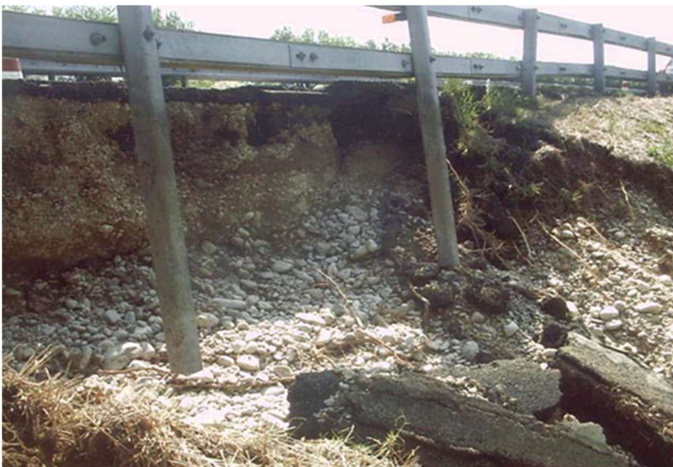
Foto 13 - 14: es. fenomeni d'instabilità che coinvolgono le scarpate dei rilevati; nella prima il fenomeno di dissesto è minimo, mentre la seconda evidenzia l'erosione della scarpata di un rilevato con asportazione di parte della corsia di emergenza per localizzata concentrazione delle acque di pioggia sulla pavimentazione
