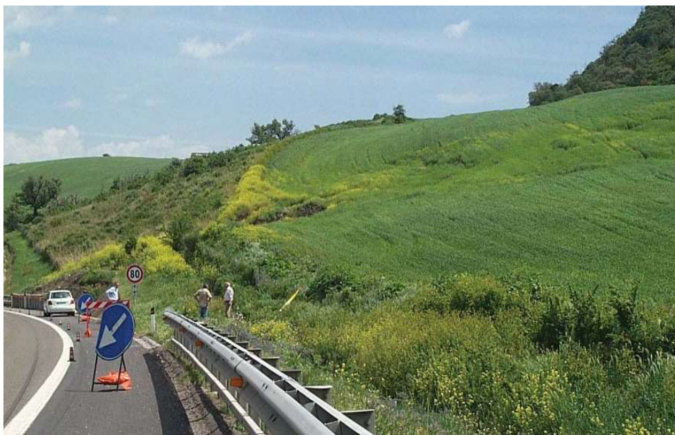
Foto 18: es. di frana rotazionale profonda che coinvolge la carreggiata e il pendio a monte; nonostante il versante a monte della carr. E sia coltivato, si notano delle fratture e contropendenze (A16 km 116+400).
