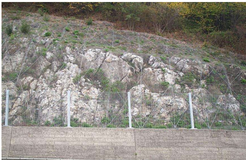
Foto 20: es. di trincea in roccia protetta con reti, rafforzamento corticale e barriera paramassi a geometria fissa installata in sommità al muro di controripa.
