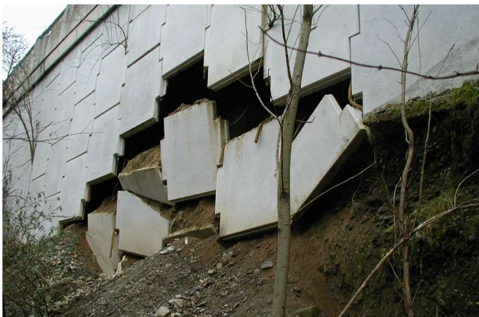
Foto 24: esempio di dissesto della struttura di un muro della tipologia "terra armata"
