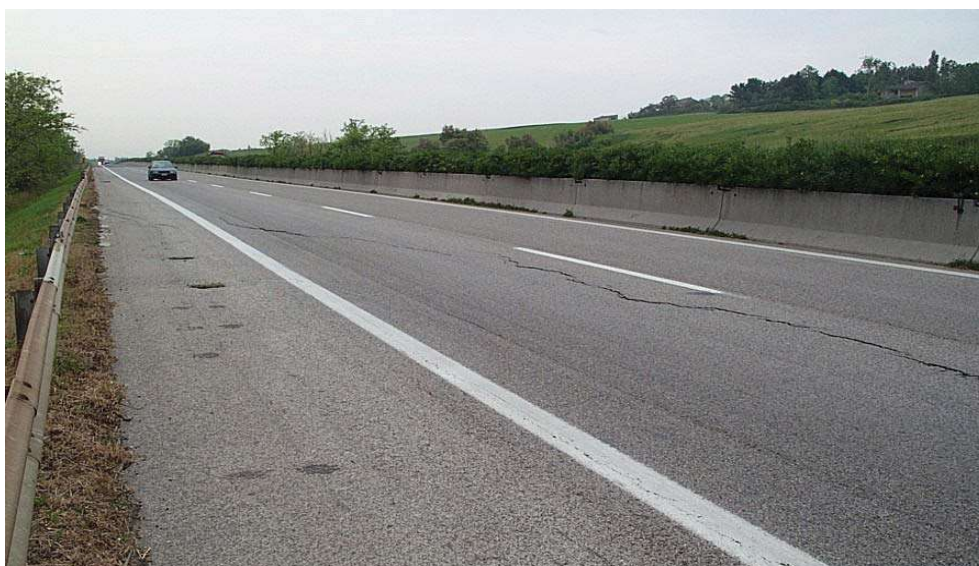
Foto 4: es. di anomalie che tipiche d'instabilità del corpo del rilevato con lesioni ad "arco" che si manifestano su tutta la carreggiata, dall'emergenza alla marcia.
