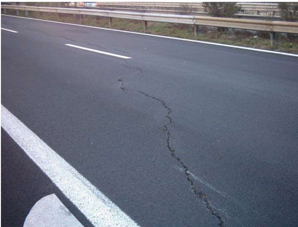
Foto 7: es. di instabilità del corpo del rilevato con coinvolgimento del piano di posa; in questo primo es. le lesioni ad “arco” e cedimenti evidenziate sulla pavimentazione della carreggiata S, si spingono fino alla carreggiata N
