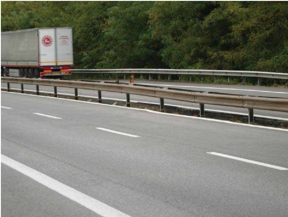
Foto 8: es. di instabilità del corpo del rilevato con coinvolgimento del piano di posa; in questo caso la lesione è trasversale all'asse autostradale e coinvolge la pavimentazione e il muretto in pietrame in dx.
