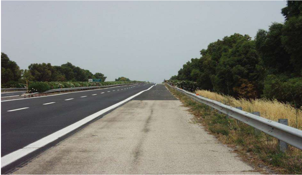
Foto 11 e 12: es. di cedimenti del rilevato
