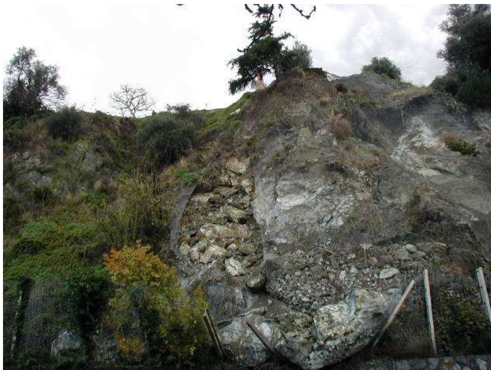
Foto 19: es. di frana di crollo che coinvolge una trincea autostradale protetta da reti e barriere di “primo impianto” (A10, carr. Est).
