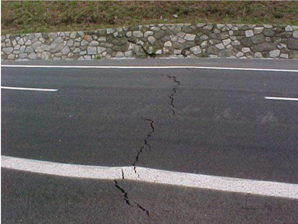
Foto 8: es. di instabilità del corpo del rilevato con coinvolgimento del piano di posa; in questo caso la lesione è trasversale all'asse autostradale e coinvolge la pavimentazione e il muretto in pietrame in dx.
