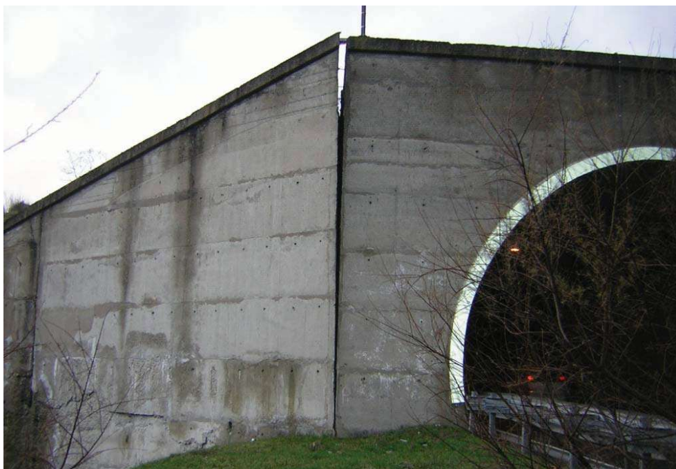
Foto 30: es. di apertura di un giunto per rotazione del muro in corrispondenza del portale
