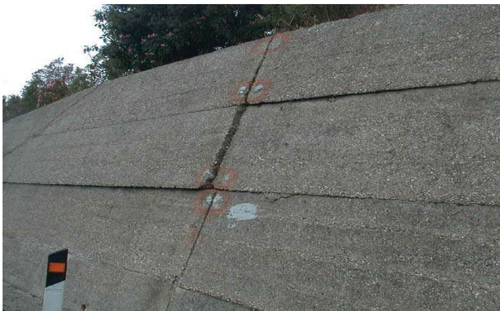
Foto 23: muro su cui sono visibili dislocazioni e rotazioni in corrispondenza dei giunti
