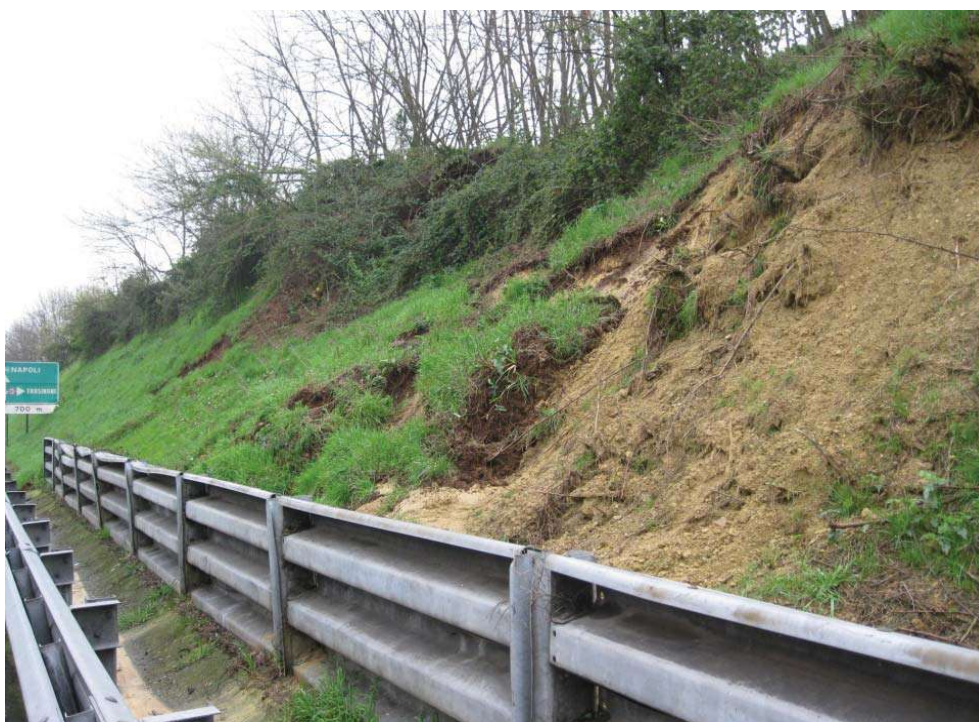
Foto 16 – 17: es. di erosione su trincea
